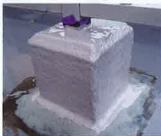
施工中 中塗り完了
