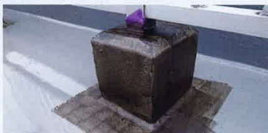
施工前 ウレタン下地にS-1R/セメント塗布済み
