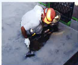
施工中 FMR-P塗布中
