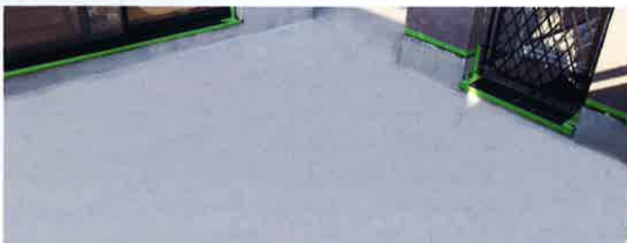
施工中 FMR-P塗布完了
