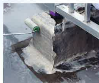
施工中 FMR-P塗布中
