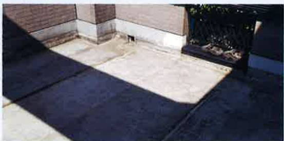
施工前 既設はFRP防水
