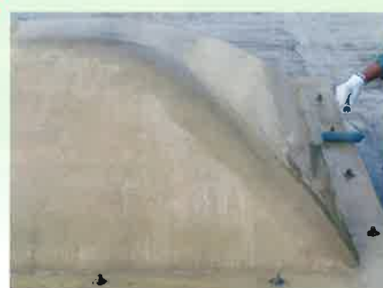
②プライマー塗布
