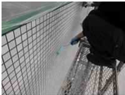
5. 補強層施工 (1層目)
