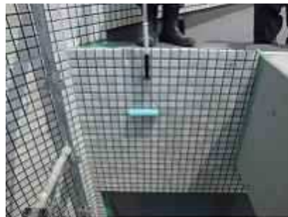
6. 補強層施工 (2層目)
