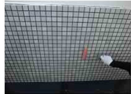
4. プライマー塗布
